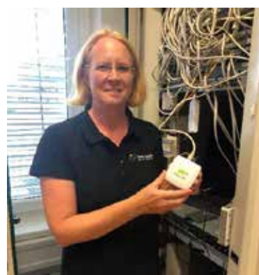
Einbau eines Efergy Strom-Monitors in der Gemeinde Empersdorf
