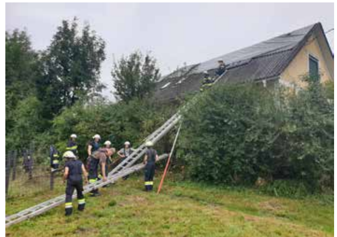
Unwetter mit starkem Hagel zerstörte viele Dächer
