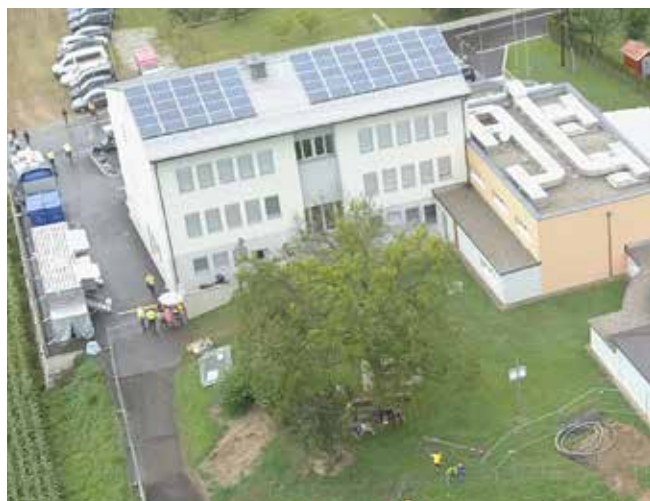
Photovoltaikanlage am Dach der Volksschule
